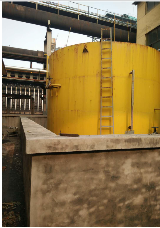
氨水罐区围堰
