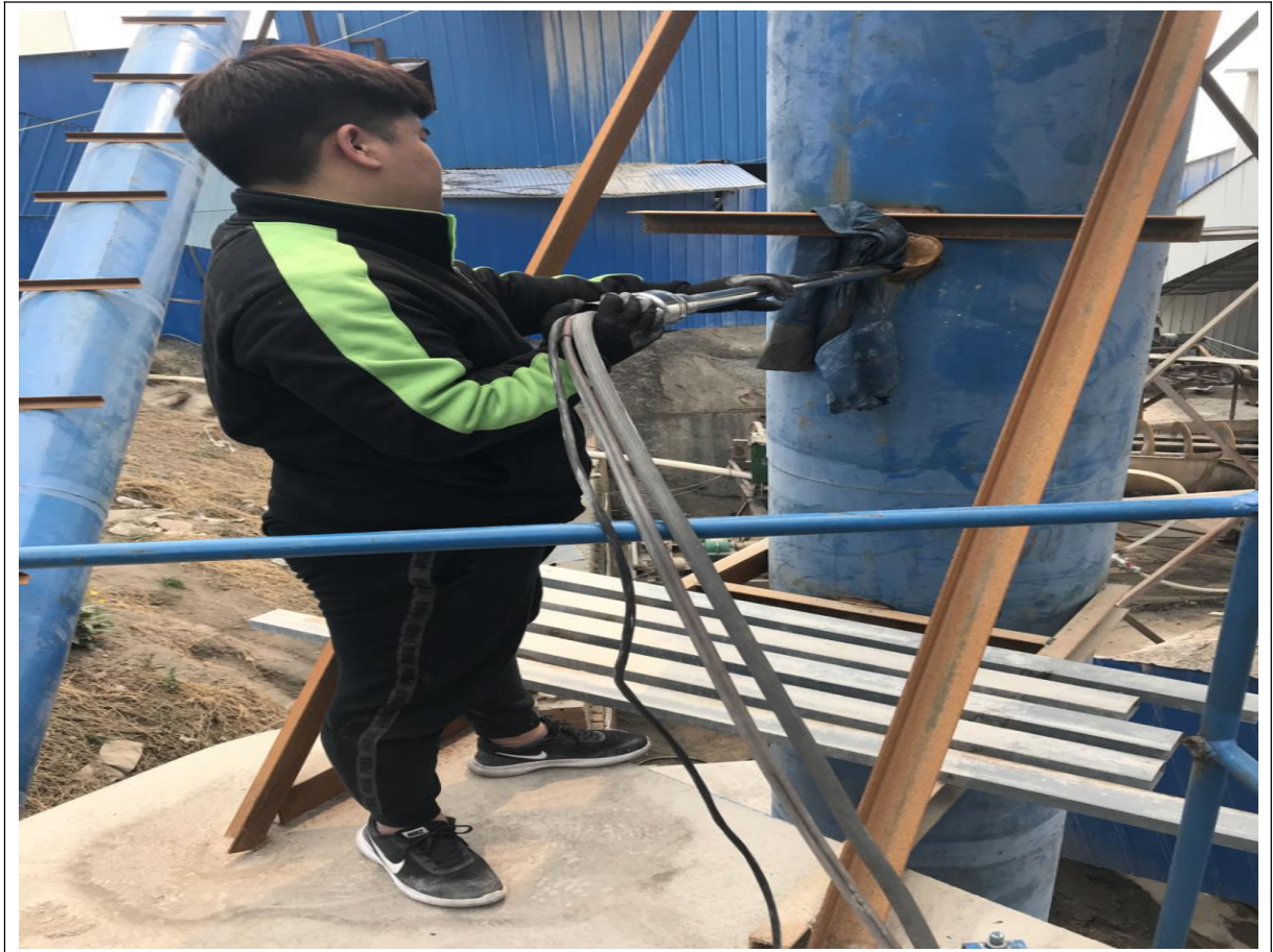
附件 7 现场检测照片（一）
